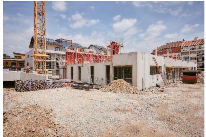
H5 en construction – Goursoll'Immo
