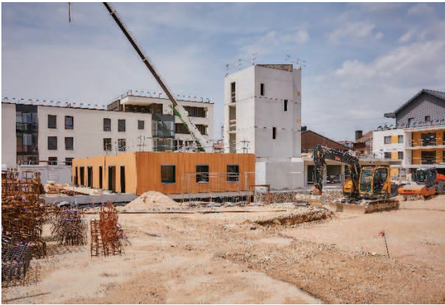
H7 en construction - Immoxis
